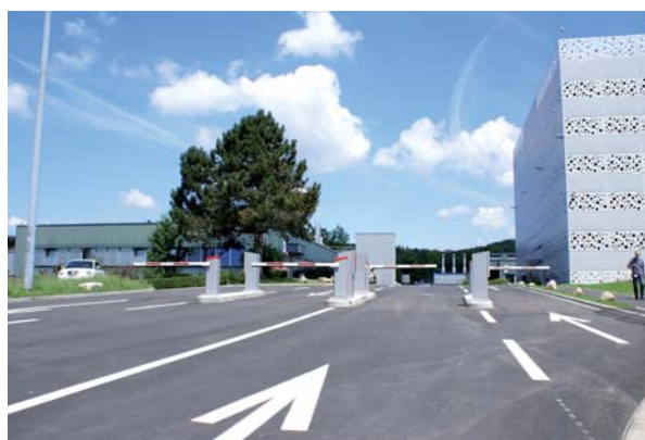
Système de stationnement évolutif. Plusieurs emplacements de stationnement sont contrôlés par une plateforme de logiciel de navigation, même à distance.
